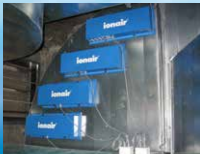
| Installation dans un climatiseur existant
